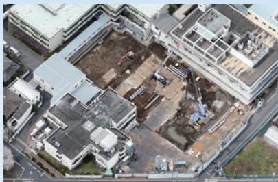
解体工事終了時 2023.3
